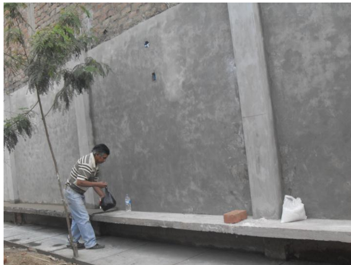
LA PARED NUEVA construida por hno. BILMO ARTEAGA
