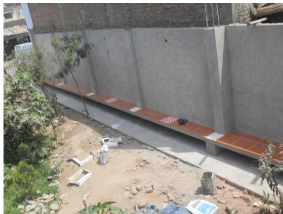
La banca completa construida con loseta y la vereda de cemento
