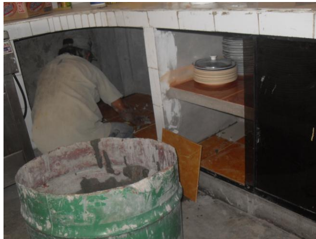
Colocación de cerámica en la cocina terminado.
